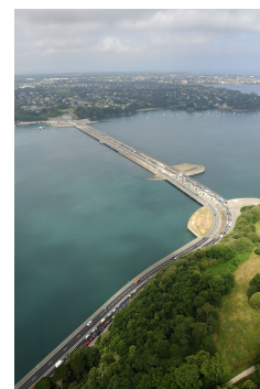
Usine marémotrice de La Rance
